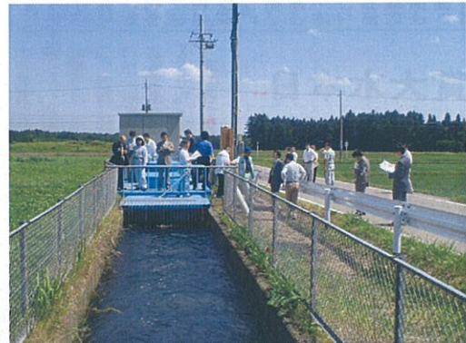
開水路落差工用小水力発電の実証試験
