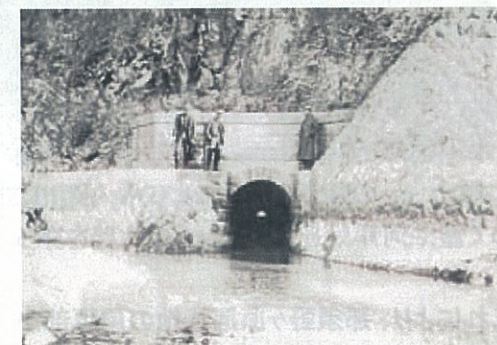
明治 18 年当時の取水口
