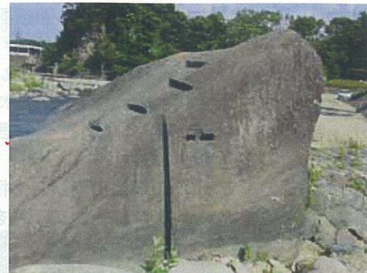
昭和4年に水門設置した第3次取水口と、現在も残る明治38年当時の自然石を利用した第2次取水口
