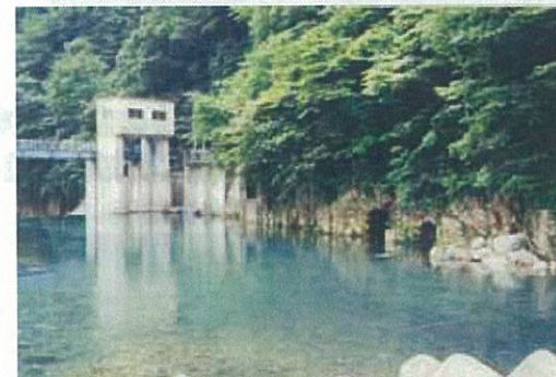
墓沼用水の新旧取水口 (岩盤に開いている穴が旧取水口)
