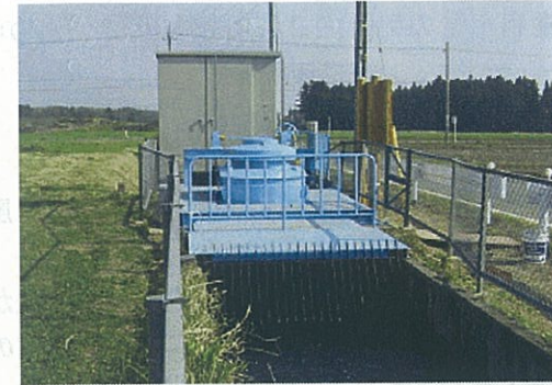
落差工を利用した発電システム (平成 17 年度設置: 4 基 = 120kw)
