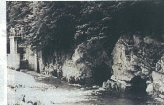
墓沼用水の新旧取水口 (岩盤に開いている穴が旧取水口)
