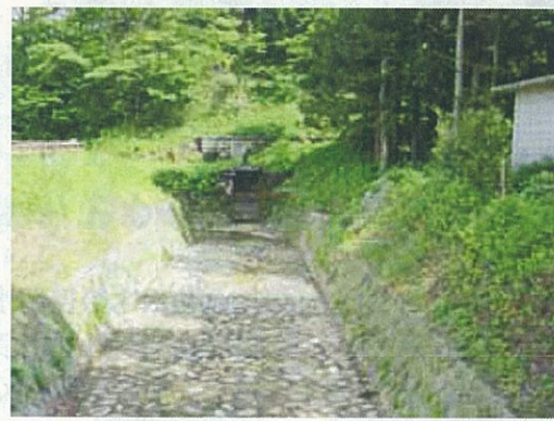
昭和4年に水門設置した第3次取水口と、現在も残る明治38年当時の自然石を利用した第2次取水口
