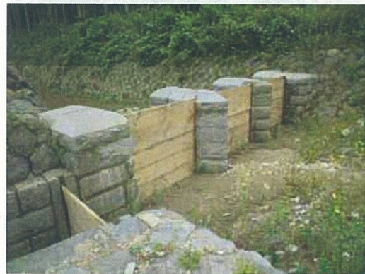
昭和4年に水門設置した第3次取水口と、現在も残る明治38年当時の自然石を利用した第2次取水口
