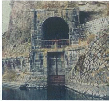
昭和4年に水門設置した第3次取水口と、現在も残る明治38年当時の自然石を利用した第2次取水口
