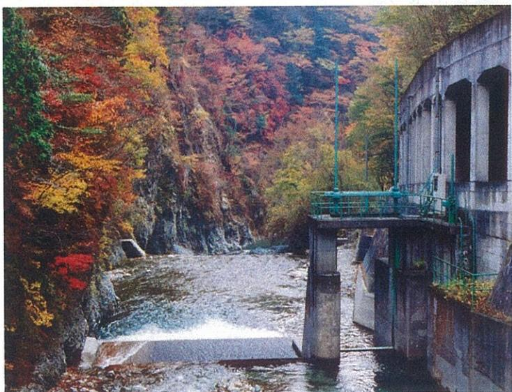
明治26年（1893）に水田開削を目的として、木ノ俣川に西俣川が合流する地点で、絶壁に数十mの隧道を掘り、以下木ノ俣川に沿って崖や河岸段丘に約4kmの水路を穿った。
