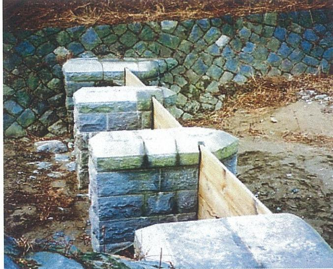
第二次取入口下流部の水量調整施設
