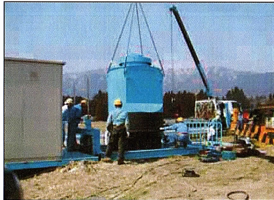
④架台の上に水車発電機を設置します
