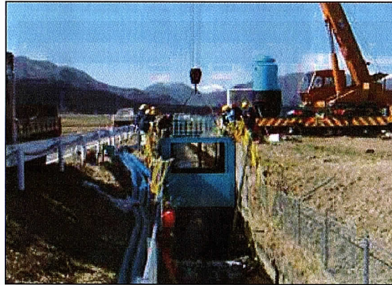
③水車発電機の架台を設置します
